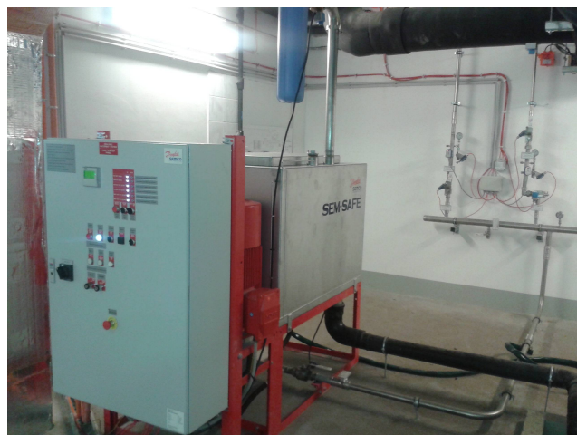
Vízköddel oltó szivattyúgépház
