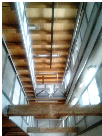
födémáttörések nyitott szórófejes tűzszakaszolása
