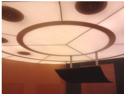
8m belmagasságú előadótér nyitott szórófejes védelmet kapott
